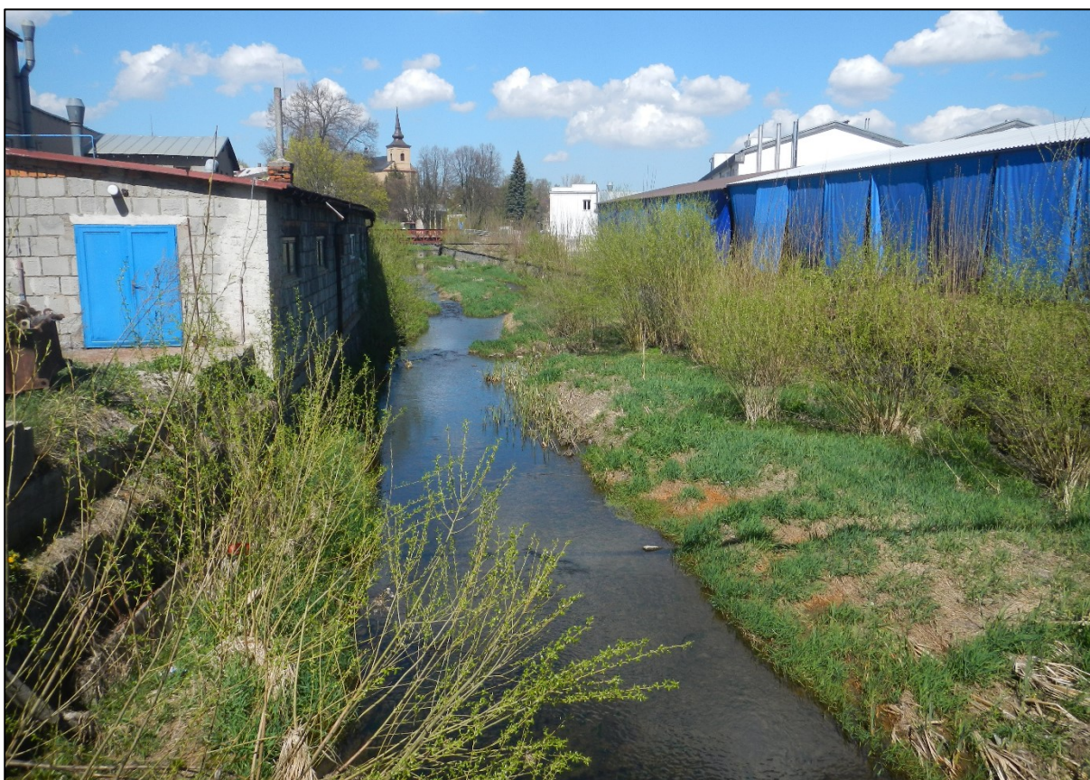
Obr. 4: SO 02, nánosy zarůstající křovinami vrb, úsek podél areálů Galvos a Technolen, 25.4.2019
