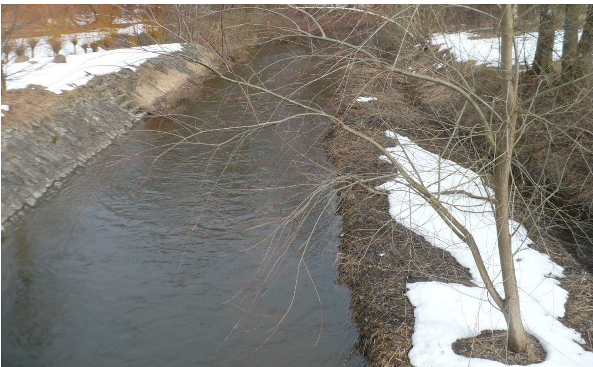
Obr. 2: Situace nánosů ve spodní části úseku SO 01 (pohled z lávky směrem proti toku, ostrov nánosů se vzrostlou vegetací dřevin), 26.2.2019
