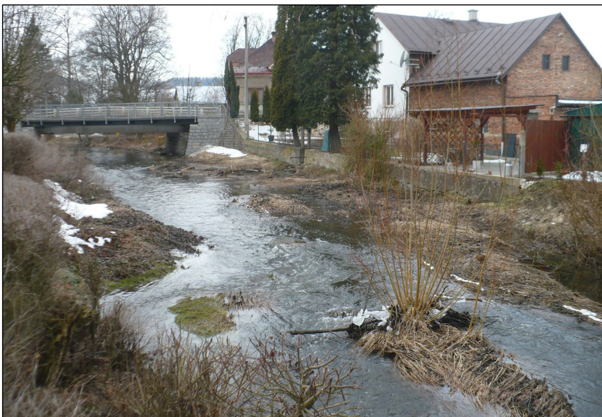
Obr. 12: SO 05 – nánosy v úseku pod mostem silnice II/343, 26.2.2019
