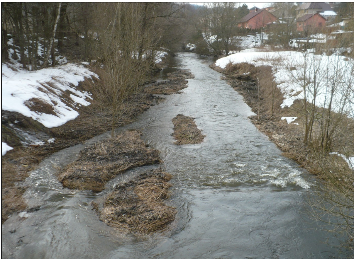
Obr. 1: Situace nánosů ve spodní části úseku SO 01 (pohled z lávky směrem po toku, konec souvislé úpravy), 26.2.2019
