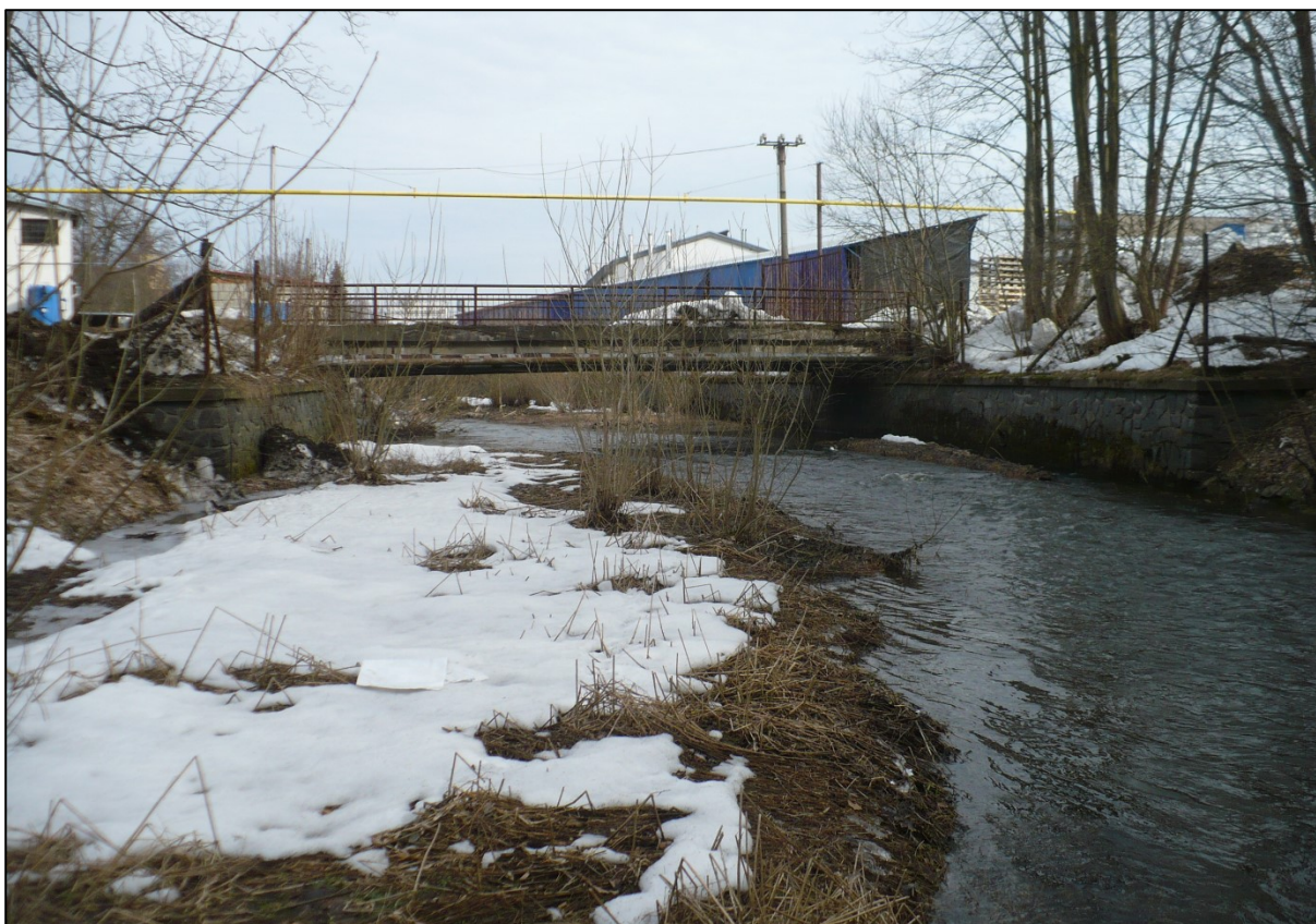
Obr. 3: Počátek SO 02 - zanesený vnitřní oblouk a mostní profil na spodním konci areálů Galvos a Technolen, 26.2.2019
