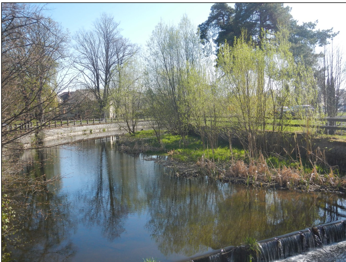
Obr. 5: SO 02, masivní nánosy ve vzdutí karetkového jezu, 25.4.2019
